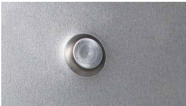
AFBEELDING PONSNAGEL VERBINDING VOOR- EN ACHTER-ZIJDE
