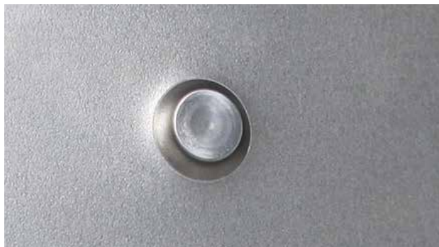
RISULTATO DELLA POSA DI UN RIVETTO AUTO-PERFORANTE
